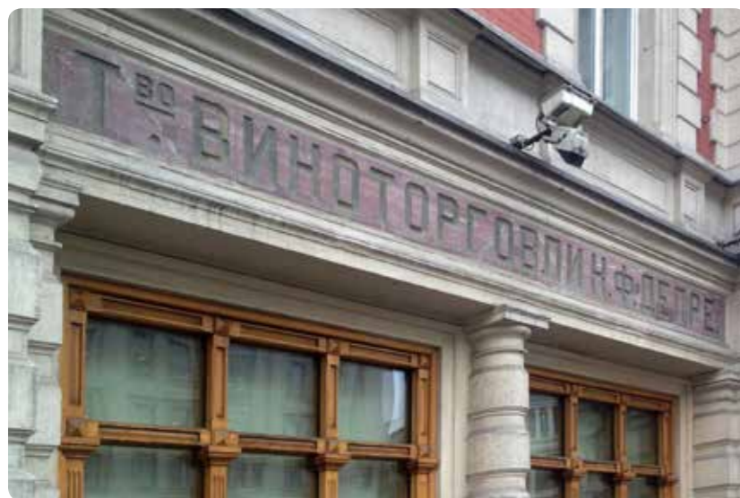
Историческая вывеска с буквами, выдолбленными в камне. Внешняя подсветка
