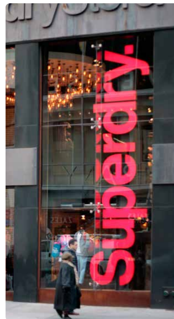
Вывеска из отдельностоящих букв с внутренней подсветкой, установленная за стеклом витрины
