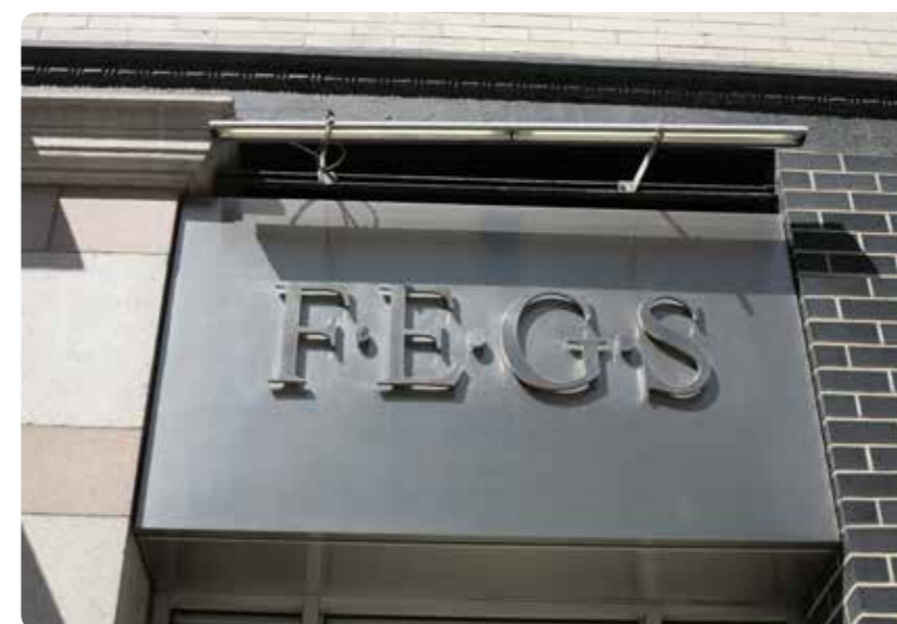
Подложка из металла. Плоские металлические буквы с внешней подсветкой
