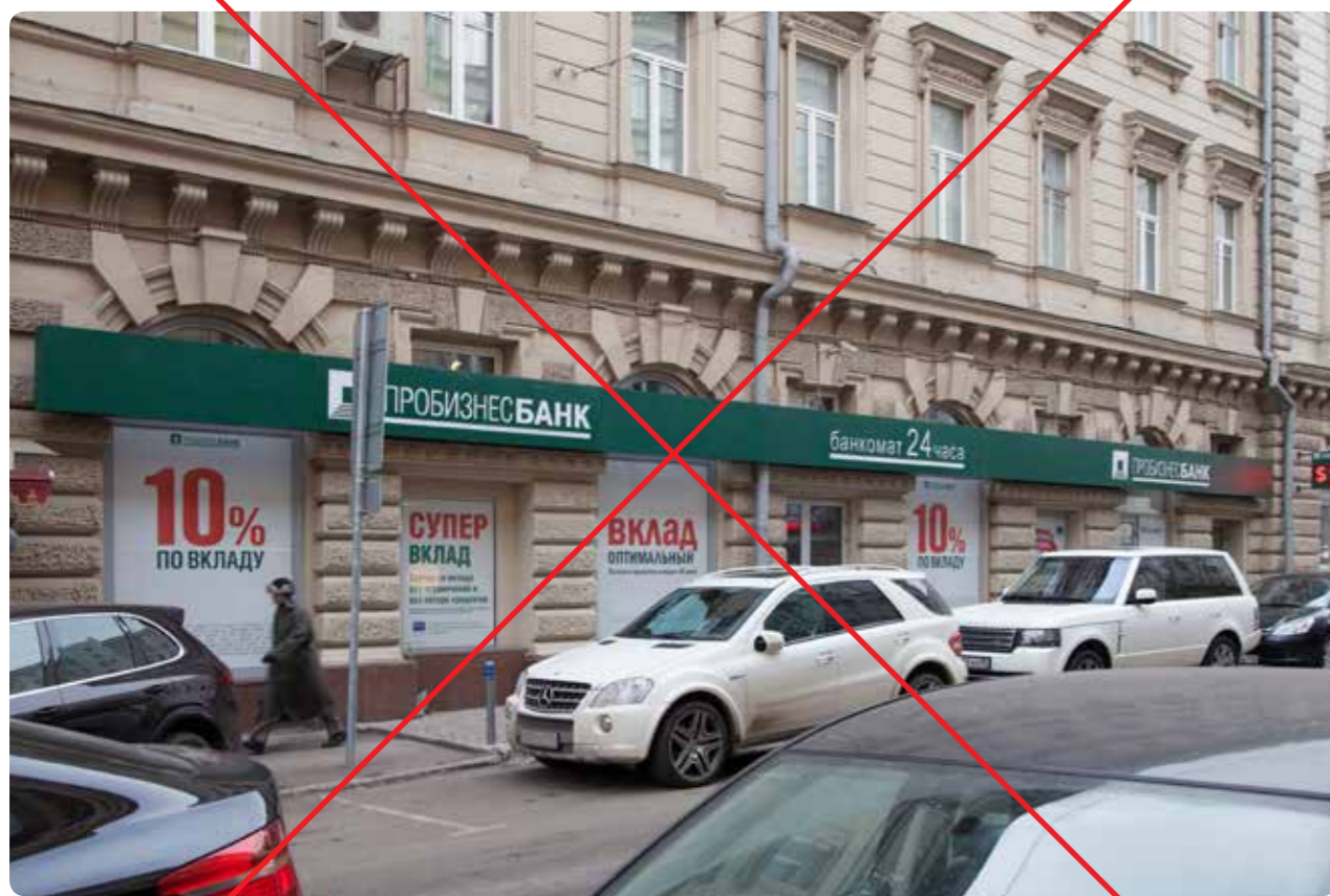
Вывеска «перечеркивает» фасад. Наглухо заклеенные витрины создают впечатление заброшенности
