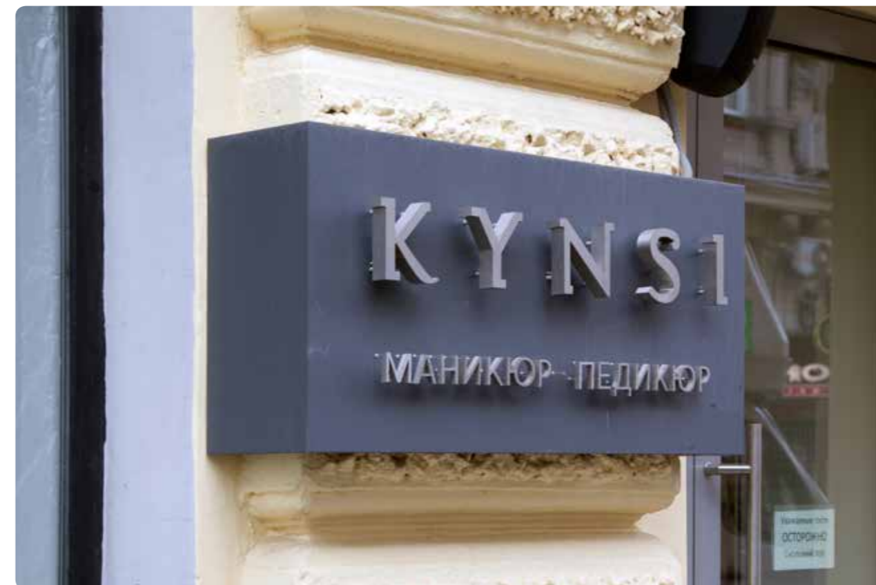
Табличка с объемными металлическими буквами на плоской подложке. Подложка специальной формы позволила удачно разместить табличку на двухрустовых камнях
