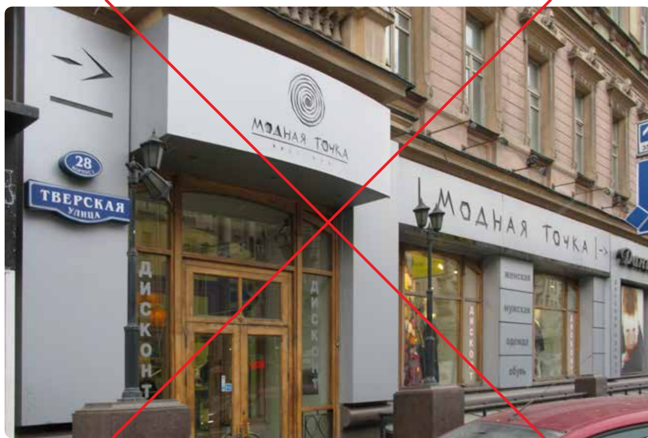
Весь первый этаж здания закрыт фальшфасадом
